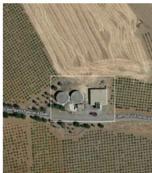
UBICACIÓN DE LA INSTALACIÓN FOTOVOLTAICA PARA GRUPO ELEVADOR Y POZO DE FECALES
